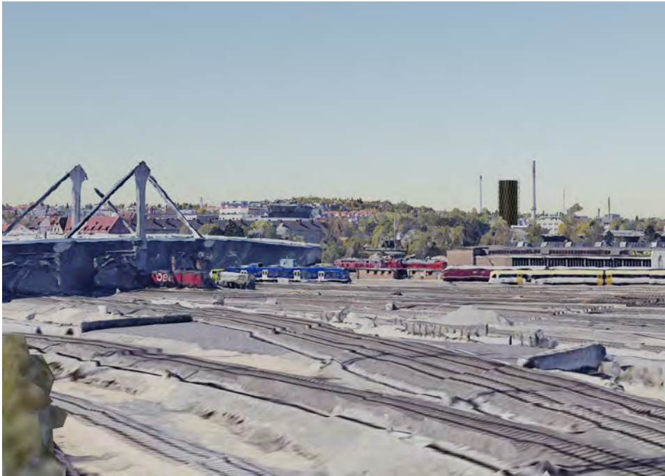
Ansicht von der Kienlesbergbrücke
